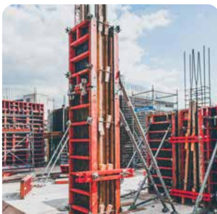
СТРОИТЕЛЬСТВО И РЕМОНТ
