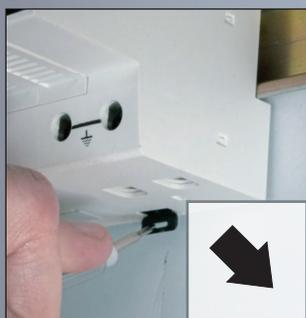
Потяните за монтажный зажим и снимите устройство.
